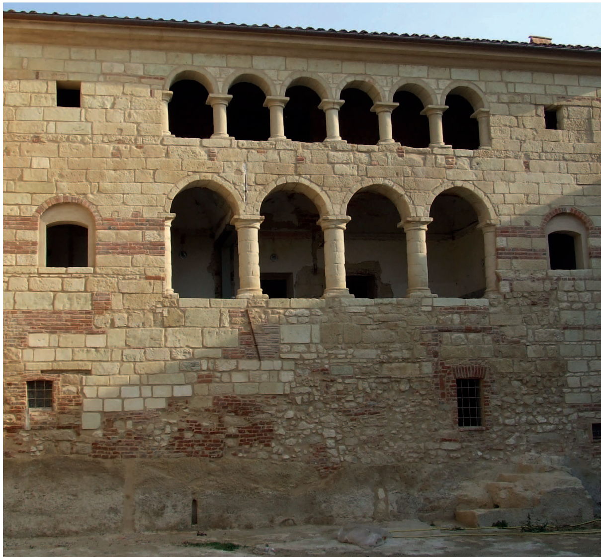
Facciata del Centro di Documentazione dell'Ecomuseo della Pietra da Cantoni Cella Monte (AL)
