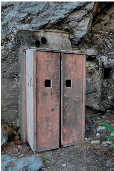
Esempio di ingresso protetto di una batteria del Vallo Alpino Occidentale.
