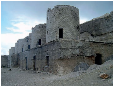
Resti della batteria dello Chaberton dal piazzale anteriore.
