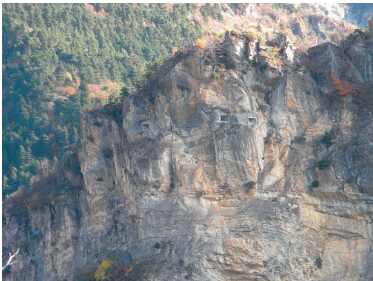
Le feritoie per arma automatica dell' Opera 244 (Alta Roja) scavata nella roccia.
