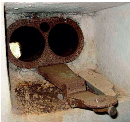
Il condotto fotofonico all'interno di un bunker, con la staffa di sostegno del fotofono solidale con la coppia di tubi immersi nel cemento.
