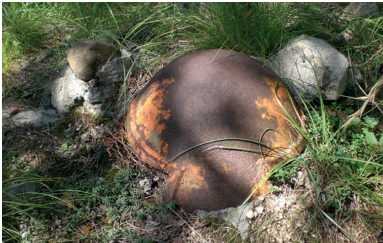
Tipica cupola corazzata per l'aerazione di un bunker.
