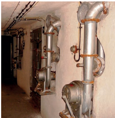
Le tre ventole di aerazione manuale per le camere di combattimento.
